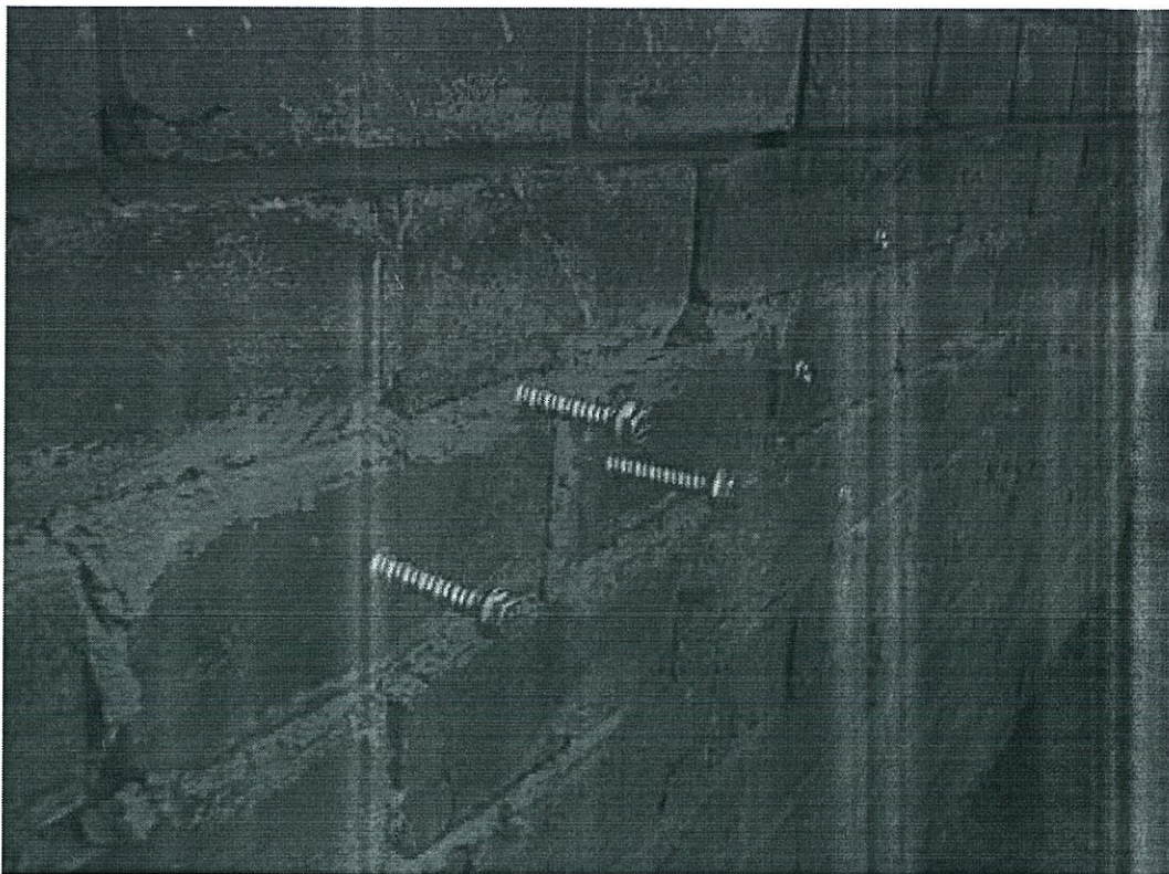
Фото 9 – Анкеры марки HUS-N, закрепляемые в кладку из вибропрессованных бетонных кирпичей, в процессе установки
